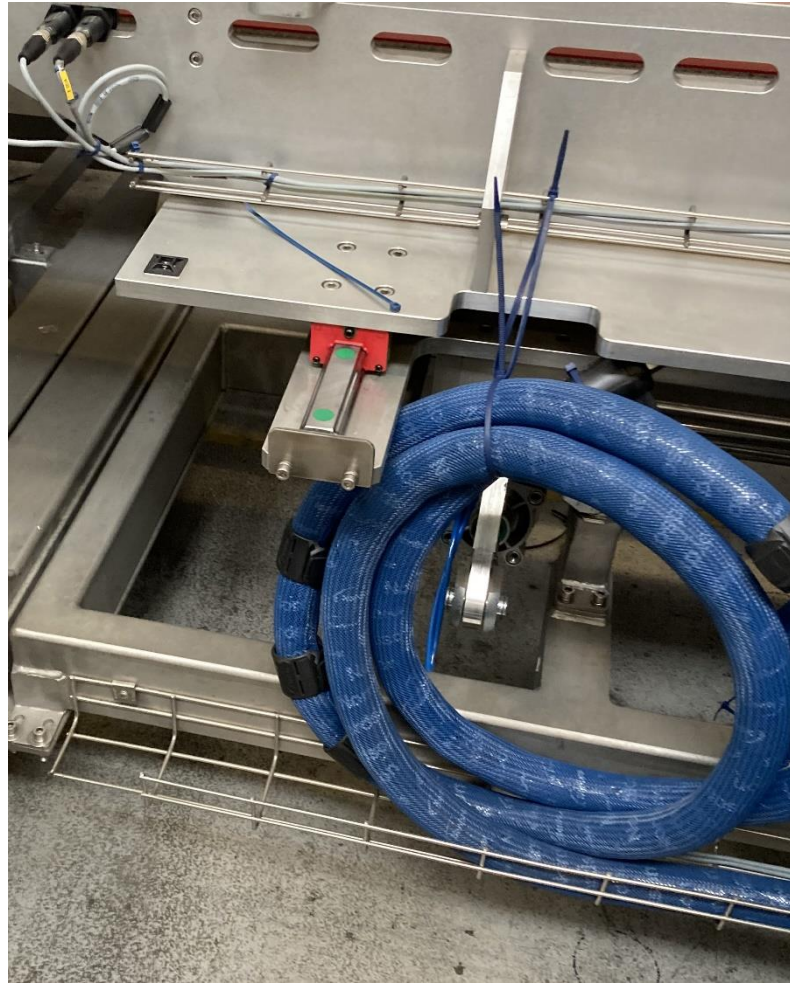
Rys. 7 Zabezpieczenie przewodów klejowych na czas transportu
